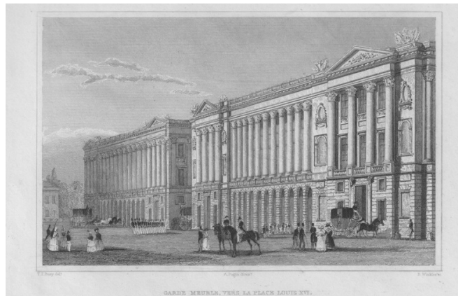
Façade de l'hôtel du Garde-Meuble
